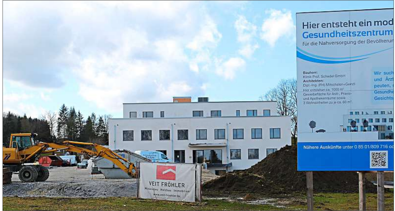
Am Fertigwerden: das Gesundheitszentrum in Kellberg. Eröffnung soll am 1. Juli sein.
